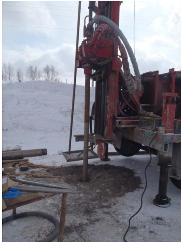
**Photo 18** : Forage du puits d'observation PO-01-14
